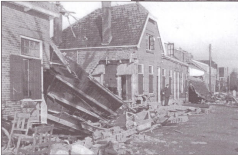
Enkele foto's van de Veerweg tijdens de watersnood 1 februari 1953.
