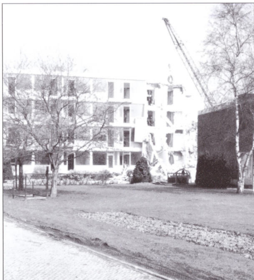
De sloop van het gebouw.
