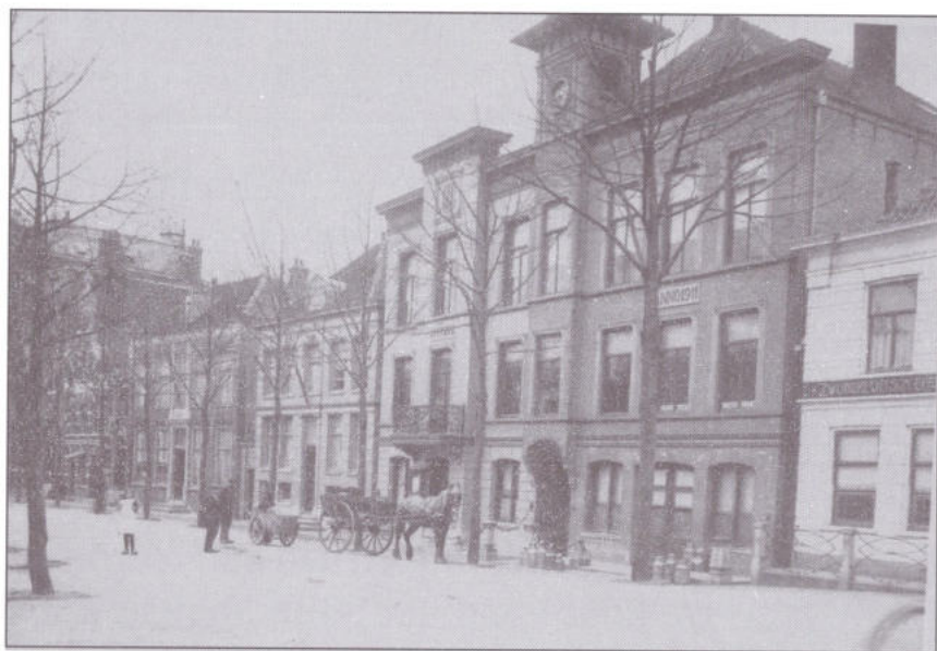
Het Veerplein, voor de sloop. Rechts het beoogde pand op de hoek Veerplein-Ringdijk
