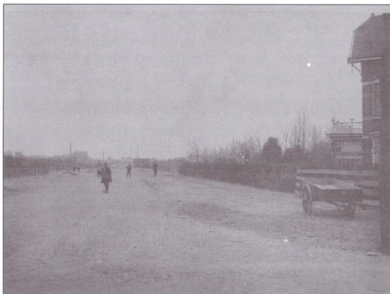
Aanleg Burgemeester de Bruïnelaan, gezien vanaf de Rotterdamseweg
