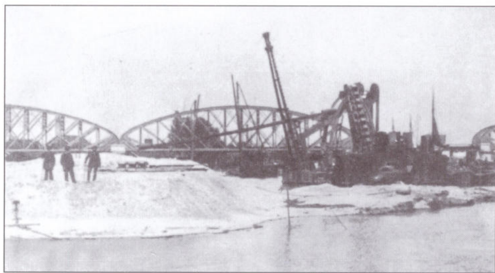
Het opspuiten van het industrieterrein, naast de spoor- brug
