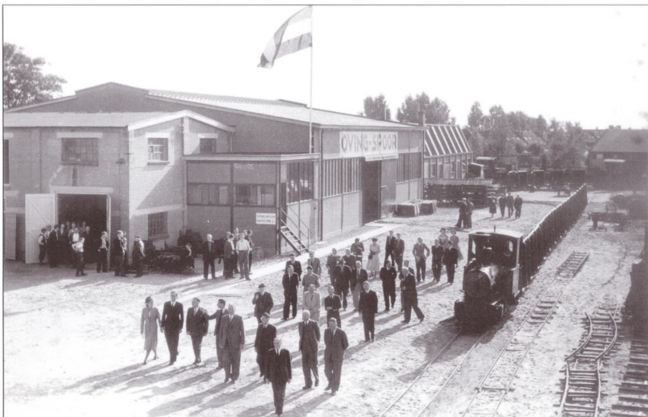
Opening van de nieuwe werkplaats en opslag van rails van Oving Spoor in H.I.Ambacht op 9 september 1949. Achter het naambord zie je nog een stuk loods van de Hollandse Beton met schedeldak.
