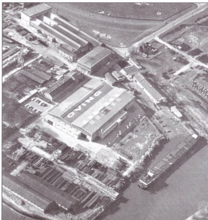
Een luchtfoto met de nieuw aangebouwde loods en kantoren in 1971. Rechts in het midden de opslag van kiepkarren in de polder de Grote Noord, waar nu de Gemeentewerf is.
