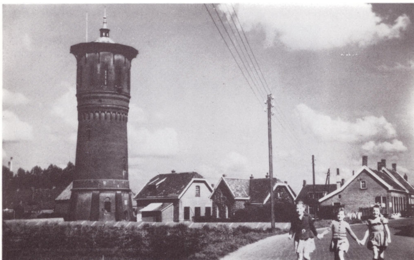
Het waterleidingbedrijf in 1952. Rechts van de toren het pompstation, links de huizen die na de watersnood in 1953 gesloopt moesten worden.
