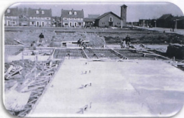
Links: De funderingen van de Vonkenberg worden gelegd. Op de achtergrond de Maranathakerk.
