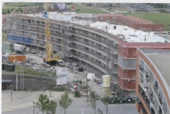
De Sophiapromenade in aanbouw.
