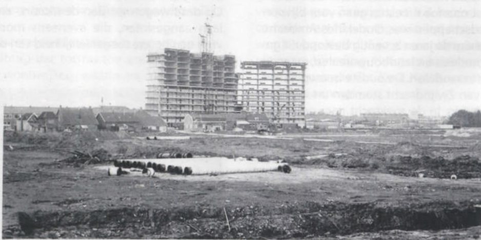
De ERA-flat aan het P.J. Oudplein in aanbouw (1973). De ERA-methode is duidelijk herkenbaar in de foto: een betonnen ombouw waarin verschillende bouwpakketten kunnen worden geschoven. Op de voorgrond zijn ook nog oude tuinderswoningen te zien aan de Slagveldstoep. Foto collectie Historische Vereniging Zwijndrecht.
