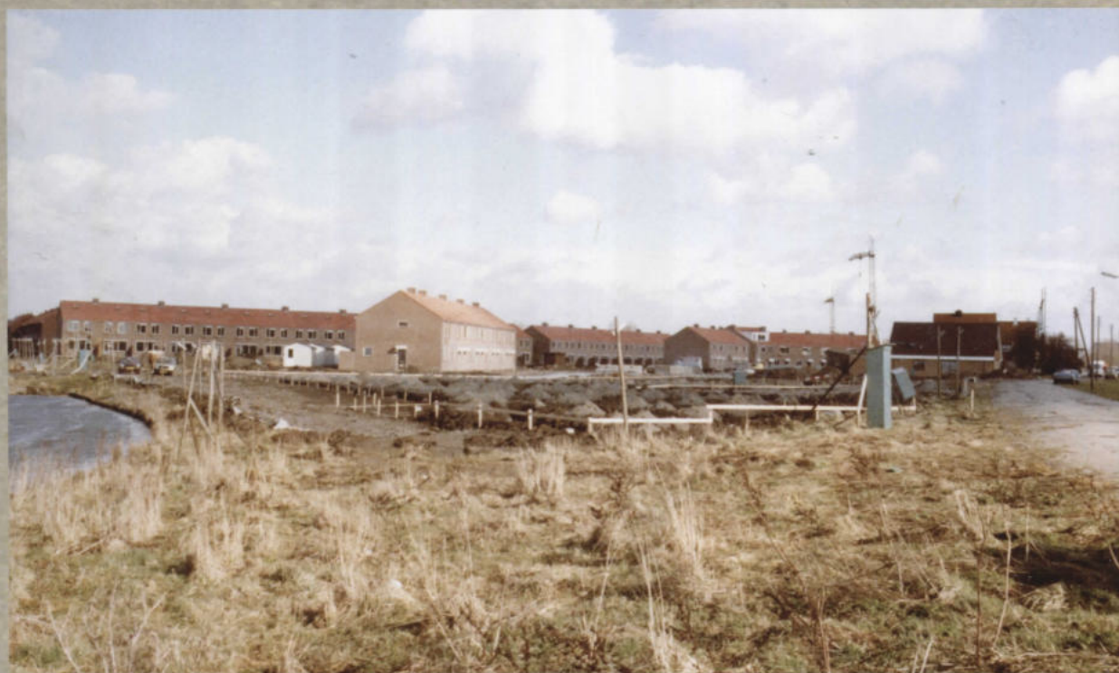
Heer Oudelands Ambacht in aanbouw. Rechts is deels nog de oude bebouwing aan de Develweg te zien. Foto collectie Kees Popijus.
