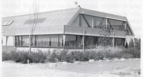
Het gebouw van Rhiant aan de Veersedijk 101.
