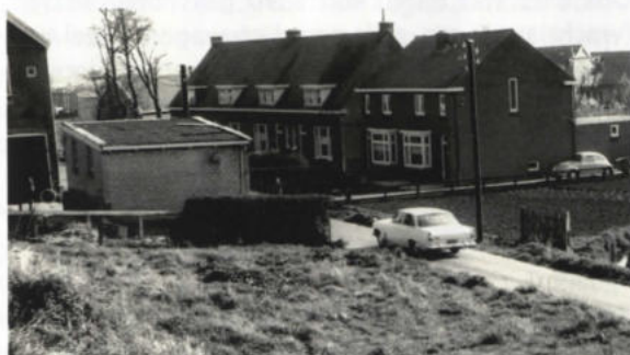
Het vierkante grijze gebouwtje is de garage waarin de gaarkeuken was gevestigd.
