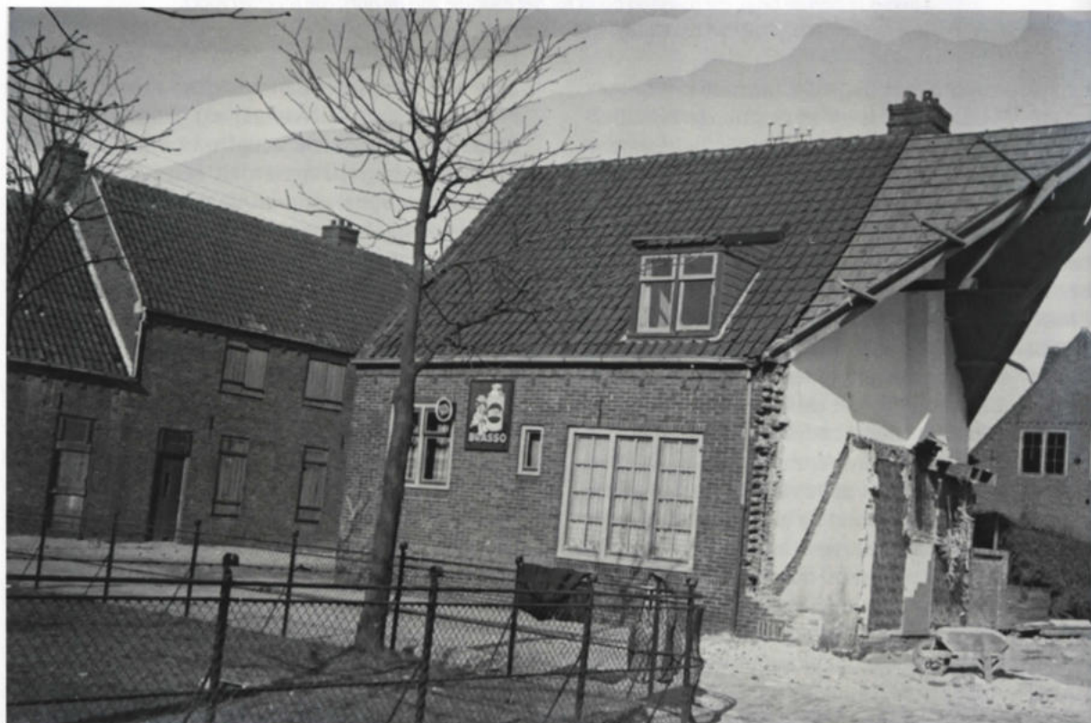
Nogmaals het tuindorp Meerdervoort maar dan een goed decennium later. Veel huizen waren in zo een slechte staat dat zij werden afgebroken. Collectie Kees Popijus.
