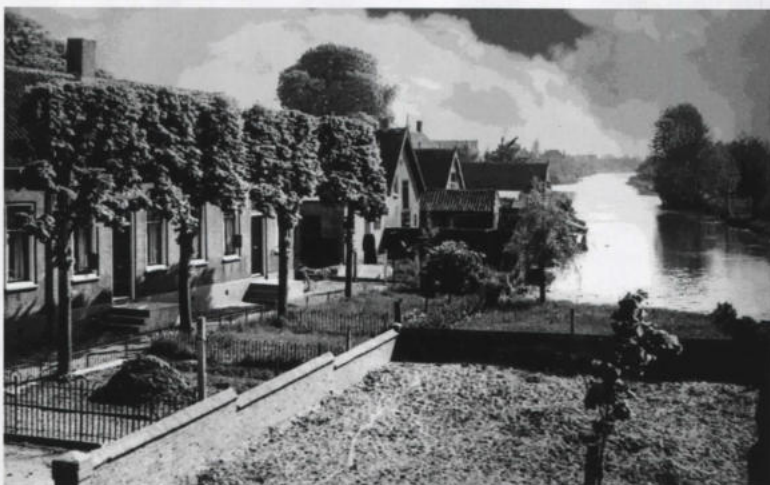
Op deze foto, die genomen is na de renovatie van de haven en omgeving zien we links de huizen achter 'Kauling' en is nog duidelijk de plaats van de voormalige sluis zichtbaar.
