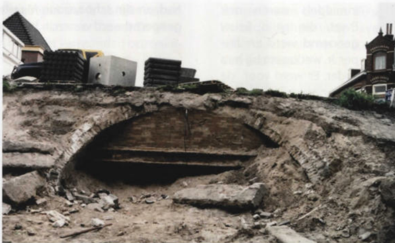
Nog duidelijk zijn hier de sluisdeuren te zien.
