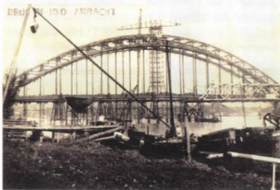
De brug over de Noord in aanbouw.
