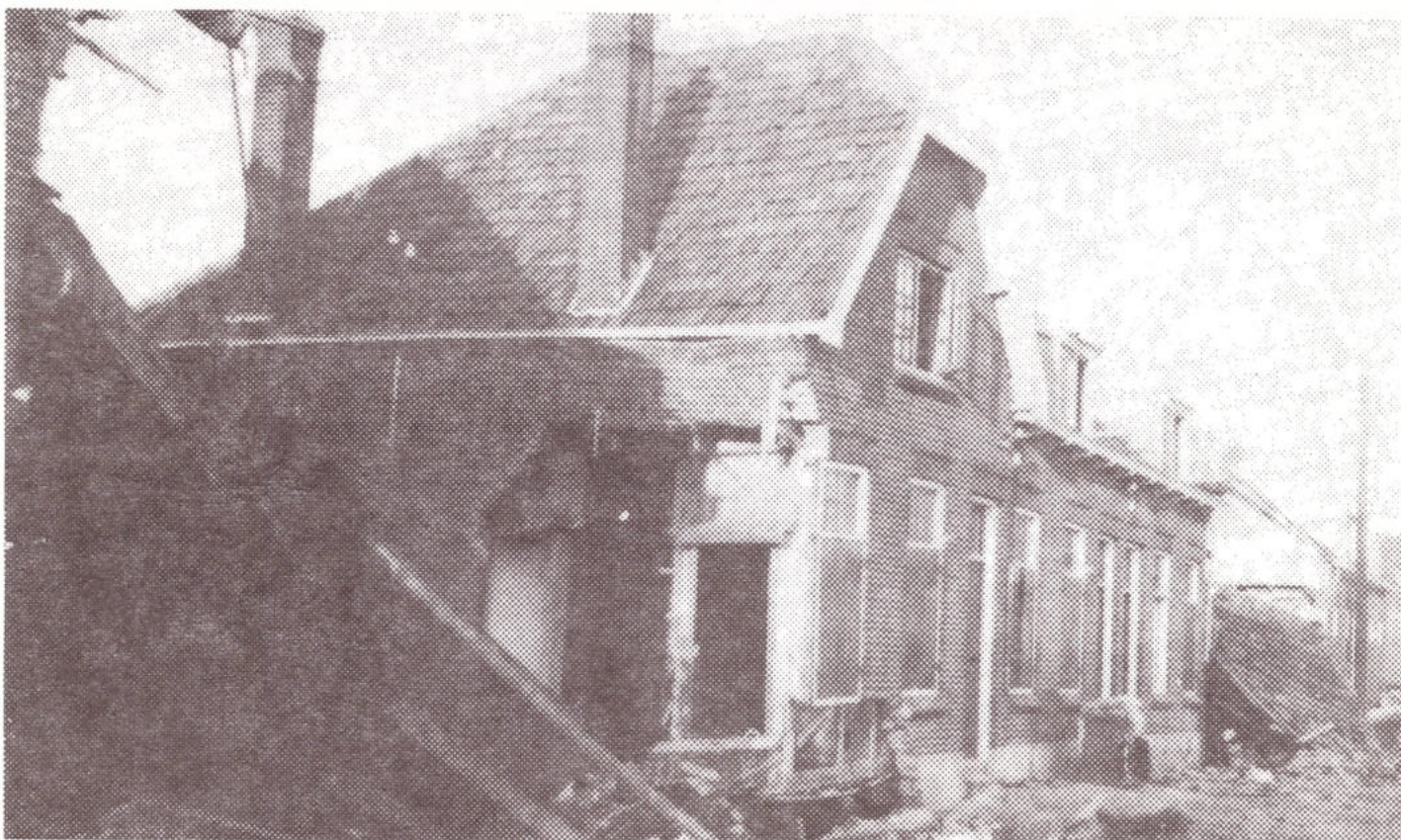
Van dichtbij ziet het er zo uit. De huizen die nog overeind stonden waren zo beschadigd dat ze moesten worden afgebroken.
