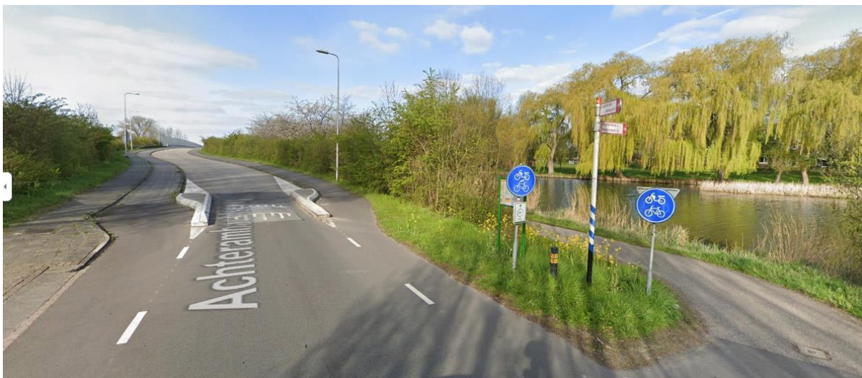
Een 'heuveltje'/wegversmalling Achterambachtseweg bij viaduct over A16
