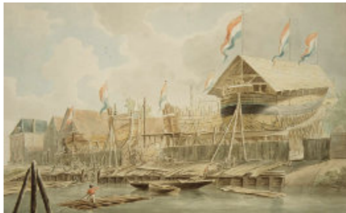
Een aquarel van E.H. Schoenmaker uit 1826 van de werf van Jan Schouten aan de Kalkhaven in Dordrecht. Dit is één van de grotere en bekendere werven in Dordrecht, maar het geeft een goed beeld van hoe een scheepshelling er precies uitzag in die tijd, en hoe belangrijk en noodzakelijk deze was voor Van der Pijpen voor het bouwen en repareren van schepen. Collectie RAD.
