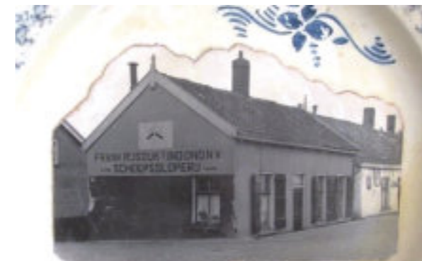
Veersedijk 41. Aan de beschadigingen op de muur is te zien dat het vrachtverkeer moeite had de bocht van de Veerweg naar de dijk te maken.
