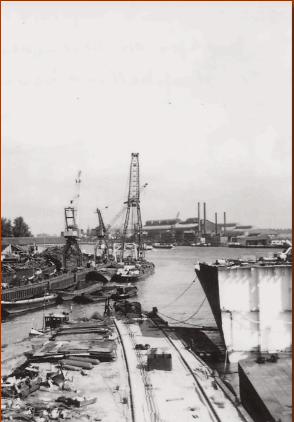
Zicht op sloperij Frank Rijdsdijk vanaf De Punt.
