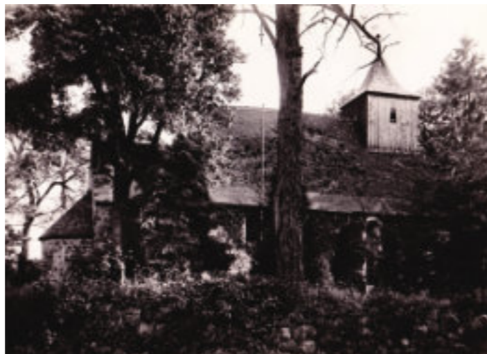
Alte Dorfskirche te Stahnsdorf.
