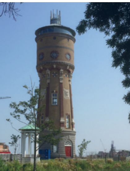
De watertoren met het nieuwe dak, gezien vanaf de Oostkeetshaven. Links in de hoek het oude torentje met het groene puntdak. Foto auteur, 2020.
