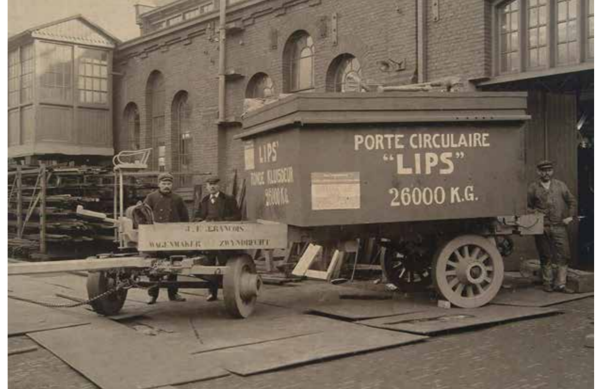
De 26.000 kilogram wegende kluisdeuren van de Dordtse brandkastenfabrikant Lips worden met een wagen, gemaakt door Jacobus Elibertus Francois, van de fabriek naar het spoor gebracht om daar per trein naar de Wereldtentoonstelling in Brussel van 1910 te reizen. Collectie Regionaal Archief Dordrecht. Gemeentelijke Prentenverzameling, inventarisnummer 552_303658.
