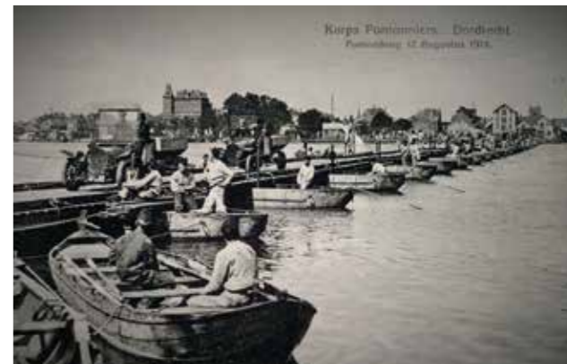
Een door het Korps Pontonniers aangelegde brug over de Oude Maas ten tijde van de Eerste Wereldoorlog. De brug was zelfs sterk genoeg om auto's te kunnen dragen. Op de achtergrond hotel het Witte Paard en de bebouwing aan het Zomerlust. Collectie Regionaal Archief Dordrecht. Collectie Gemeentelijke Prentenverzameling, inventarisnummer 552_406350.
