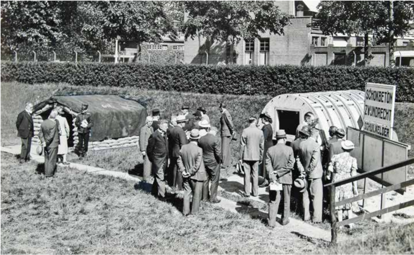
Een tentoonstelling van deVereeniging voor Luchtbescherming in Dordrecht, waarbij o.a. een uit geprefabiceerde segmenten opgebouwde schuilkelder van Schokbeton uit Zwijndrecht werd getoond. (bron: Beeldbank RAD)
