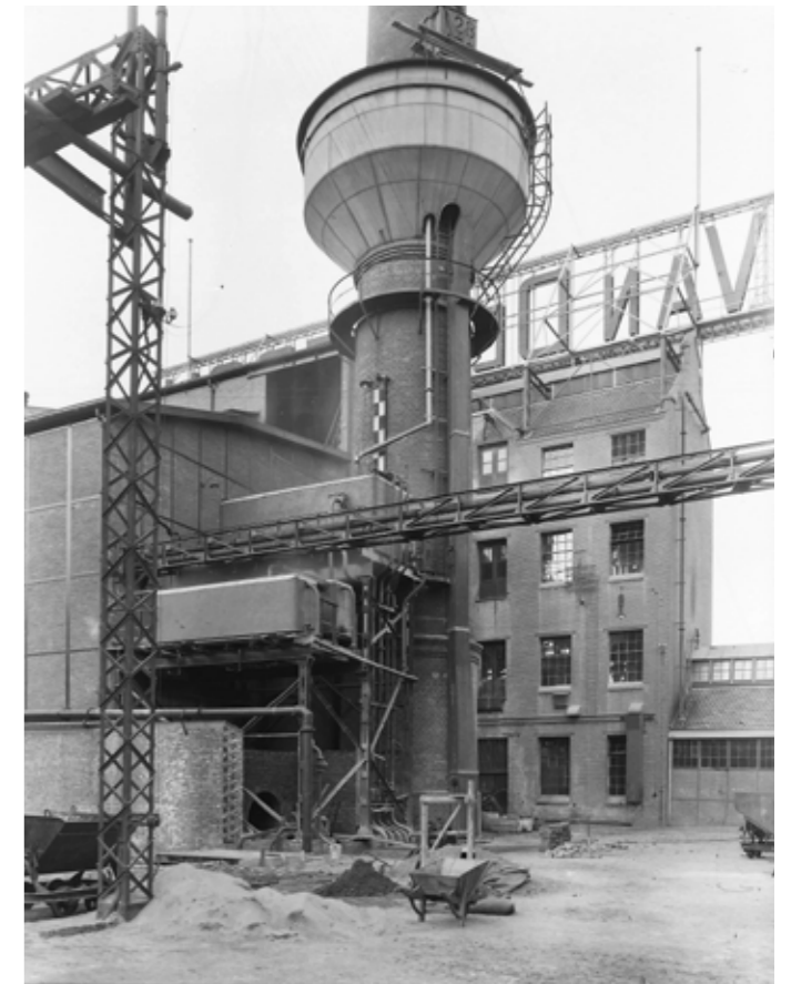
Schoorsteenreservoir van Van den Bergh's Vereenigde Zeepfabrieken, 1924. Collectie RAD
