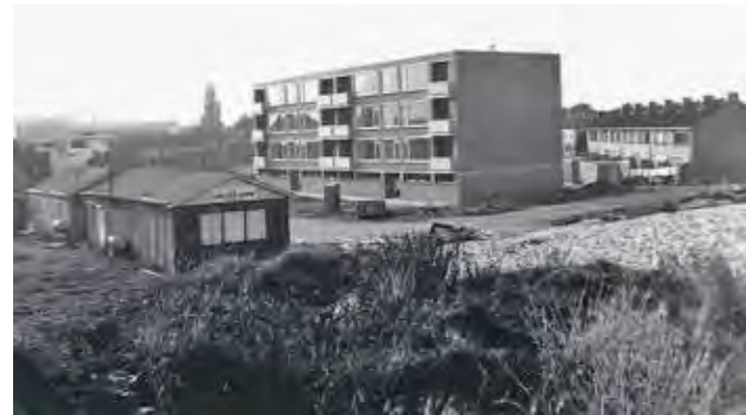
De bouw van de flats aan de Emmastraat beginjaren 70. Rechts de Willem Frisostraat en daarachter de nieuwbouwwoningen van het Oranjeplein. Facebookpagina Oud-Zwijndrecht
