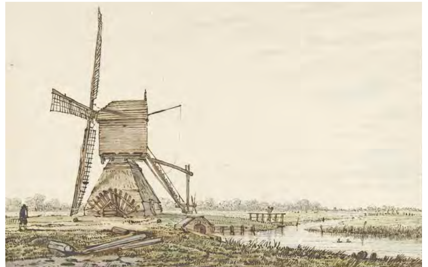
Van de Ambachtse watermolens zijn geen afbeeldingen overgebleven. Deze penseeltekening van Jacob van Strij betreft een wipmolen, het oudste type watermolen, in de omgeving van Smitshoek en dateert uit de achttiende eeuw. Dit soort wipmolens stonden ook in Ambacht. Het 'wippen' heeft betrekking op het schudden van de molen als het hard waaide. Collectie Rijksmuseum
