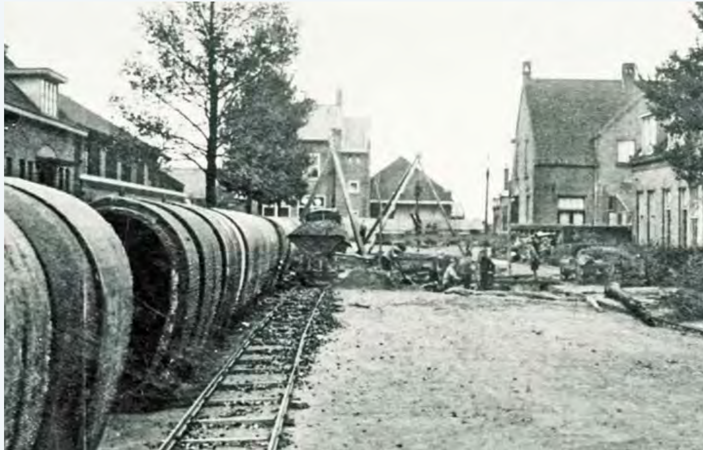
Rioolwerkzaamheden in de Emmastraat in de jaren dertig van de vorige eeuw. Collectie Kees Popijus
