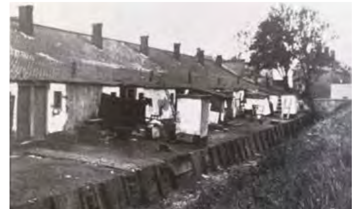
Het bekendste voorbeeld van krotwoningen in Zwijndrecht waren de 'Franse Huizen' op de Ringdijk nabij de glashut en Oostkeetshaven. Collectie HVZ
